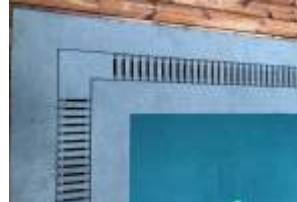
Производим бортовые элементы с системой переливной решетки из монослоистого 2-х сантиметрового керамогранита. Взамен стандартной пластиковой переливной решетки имеющей срок службы 3-4 года.
