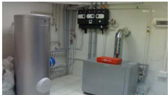
▲ Котельная частного дома работает по датчику наружной температуры, автоматически сокращая расход газа. Оборудование Viessman (Германия). Трубопроводы - медь.
