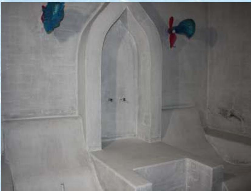
Хамам запроектирован по пожеланию заказчика с эргономичными креслами и системой каскадных душей. На фото начало этапа нанесения жидкой нанокерамической экологически чистой теплоизоляции после формирования конструктивных элементов.
