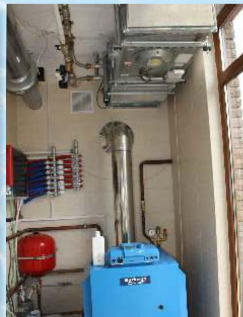
Так выглядит сердце этого СПА-комплекса. Котел Buderus Logano (Германия) с многоконтурной системой отапливает помещения, нагревает воду бассейна и приточный воздух системы вентиляции. Все системы спроектированы и смонтированы нами «под ключ». Парогенератор и система аромодозации хамама находятся здесь же.
