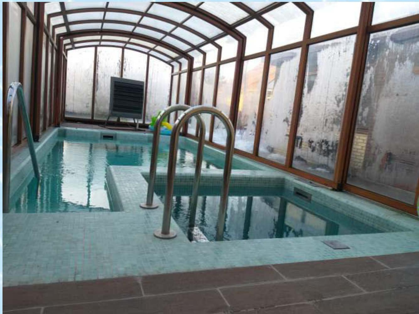
Для круглогодичного использования смонтированы сдвижной павильон и система воздушного отопления.
