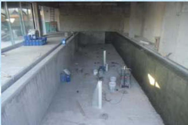
Переливной бассейн 18x5м. Начало работ по устройству гидроизоляции чаши.
