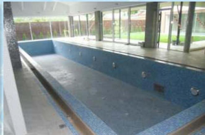
Чаша бассейна после окончания отделочных работ и установки закладных деталей из нержавеющей стали.
