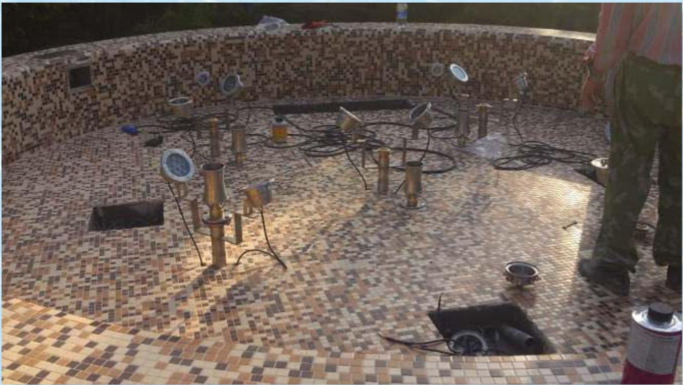
Заключительный этап строительства фонтана. Идет монтаж насадок и системы подводной подсветки.
