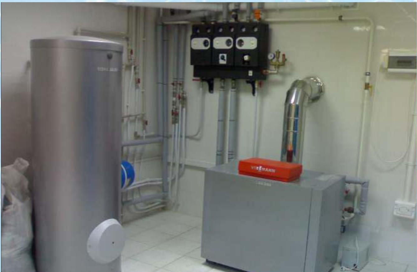
Котельная частного дома работает по датчику наружной температуры, автоматически сокращая расход газа. Оборудование Viessman (Германия). Трубопроводы - медь.
