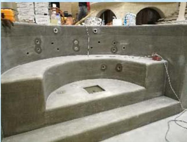
Гидромассажная зона бассейна на 3 места с различными типами форсунок и аромассажным гейзером (вид после окончания гидроизоляционных работ).
