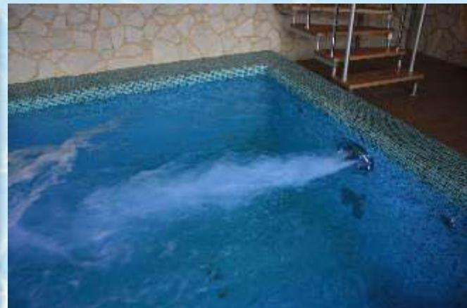
Работает противотечение фирмы Pahlen (Швеция). 2 массажных сопла D 40мм. с регулируемым напором. Используется для плавательных упражнений и гидромассажной терапии (опционально подключается шланг для подводного массажа).
