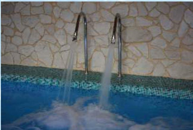
Система массажных водяных пушек Flexinox (Испания) со сменной системой насадок. Работают плоская веерная и трехструйная насадки. Насадки быстросменные, всего бывает 5 типов с разными эффектами массажа.
