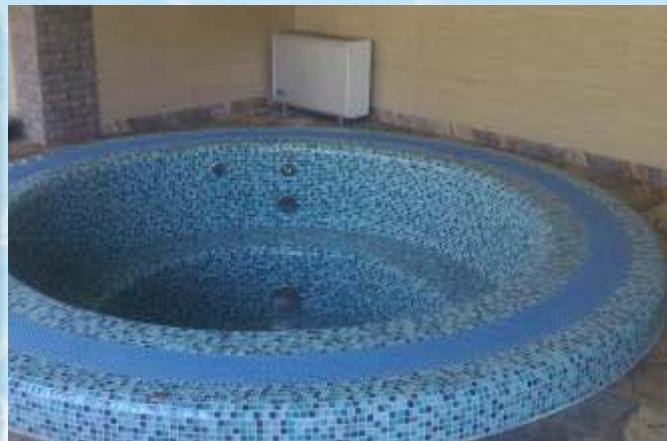
Все готово к заполнению водой и пуску в эксплуатацию. В углу установлен осушитель воздуха для удаления избыточной влаги в помещении.
