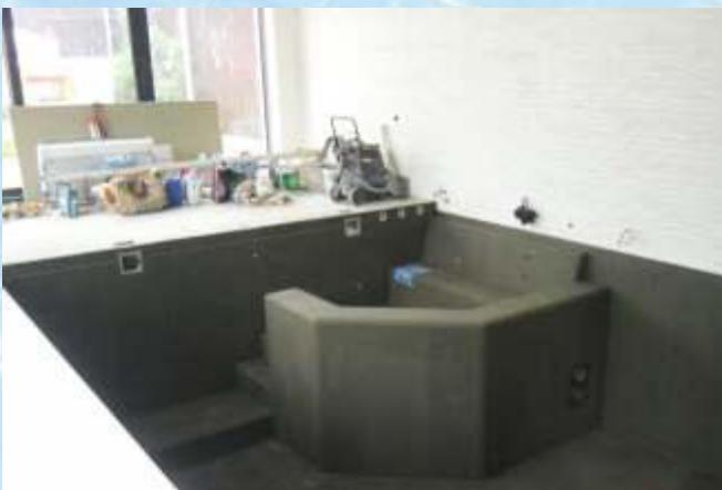
Вид бассейна 3,4х6 м. со встроенной гидромассажной зоной после окончания гидроизоляционных работ по чаше.
