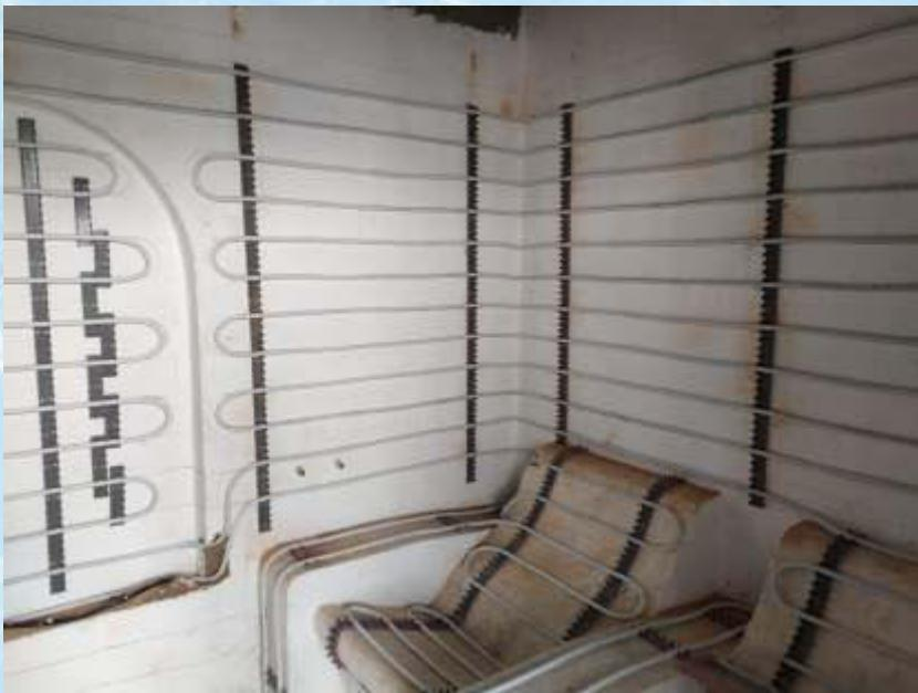
Хамамы строятся нами по традиционной турецкой экотехнологии без применения новомодного вредного для человека полистирола на нагреваемых поверхностях. Инновационная обмазочная теплоизоляция имеет толщину всего 6(шесть)мм, заменяя при этом 6 см полистирола.
