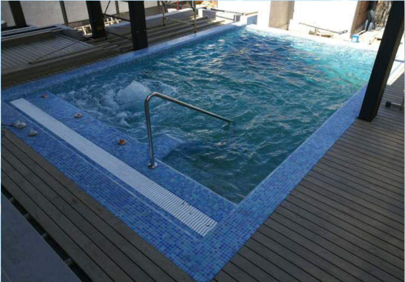
Этап № 3. Гидроиспытания готового бассейна. В переливном бассейне 7x4 м. реализована система каскадного водопада на фасадную сторону и создана полноценная СПА-зона на 2 гидромассажных места и донный гейзер для детей.
