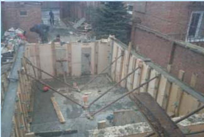
Этап №1. Окончание строительных работ по монолитной железобетонной чаше.
