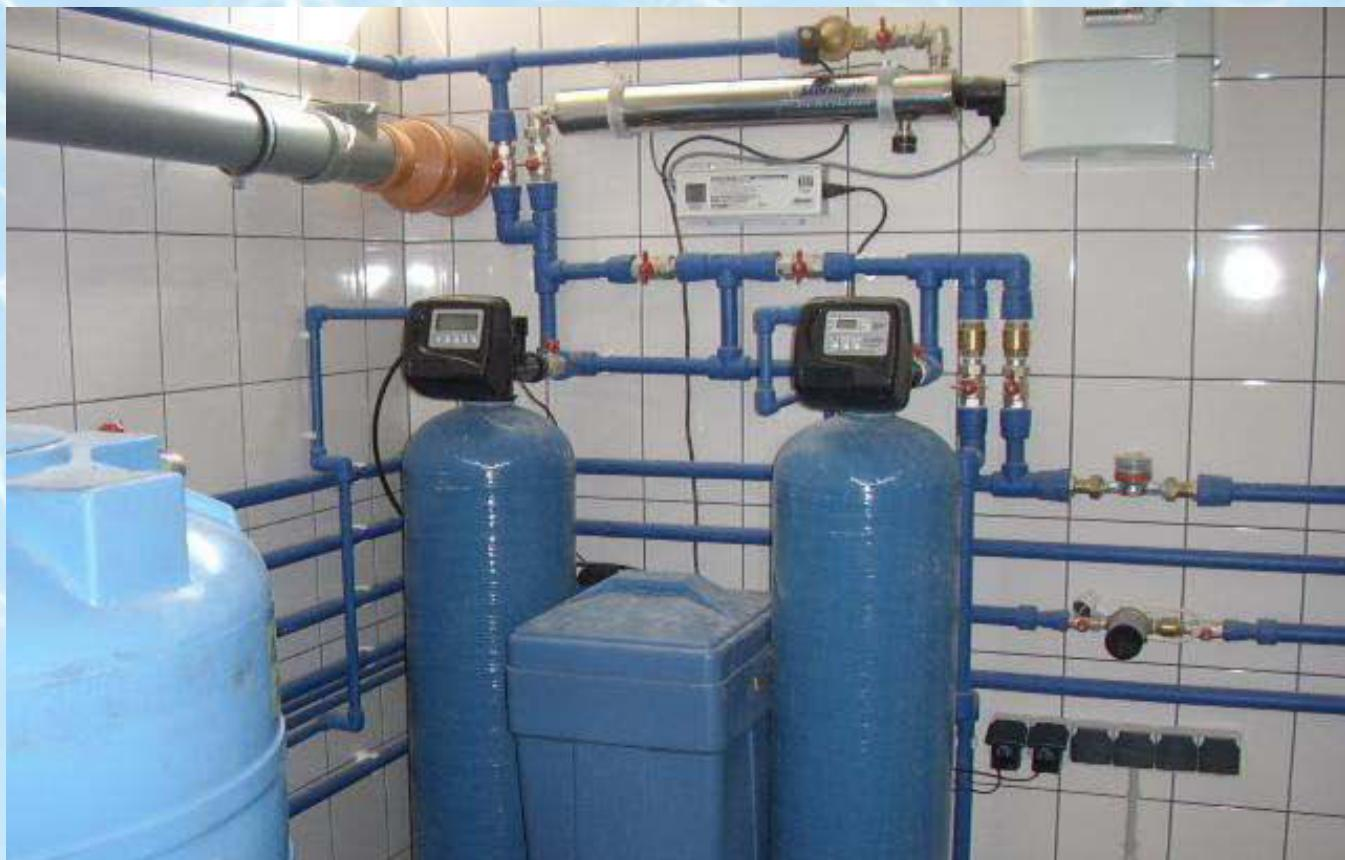
Система водоподготовки частной резиденции для автономного источника воды с повышенным содержанием органических примесей.
